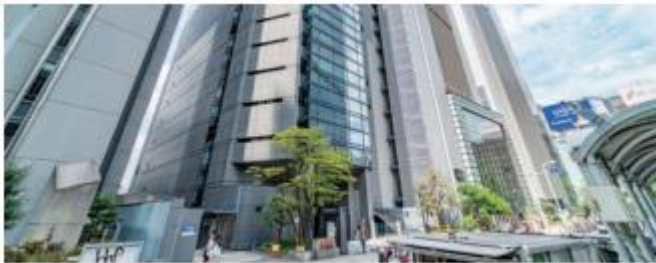
東京建物梅田ビル 外観
