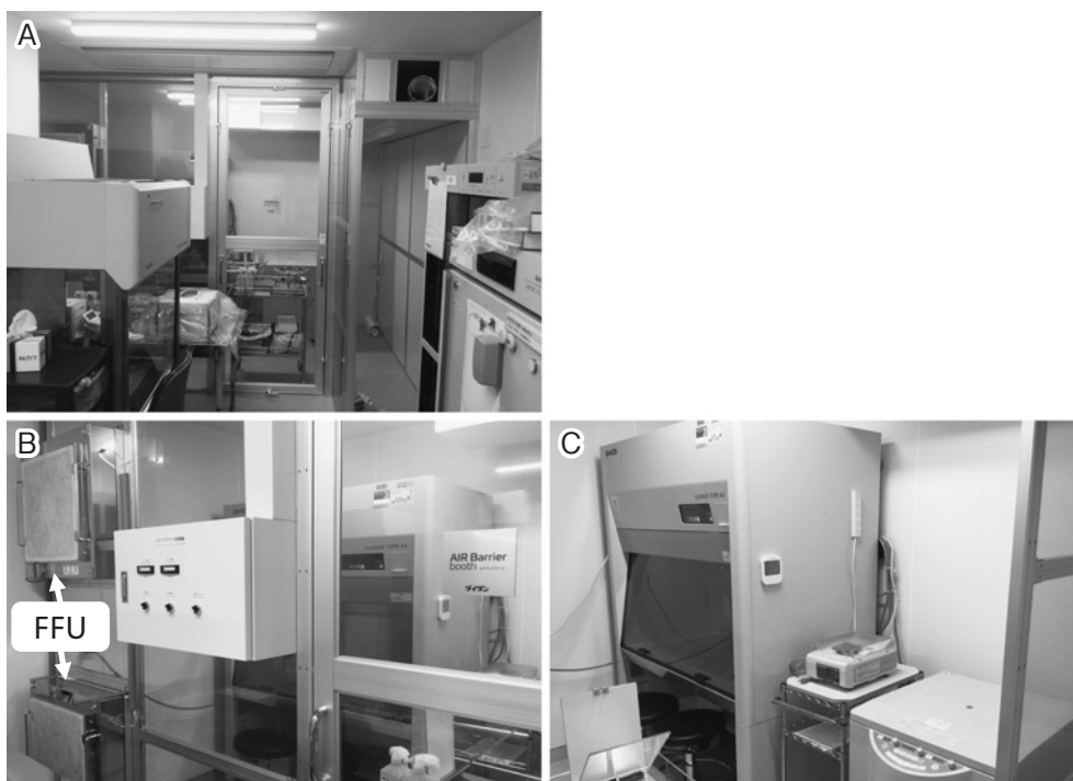
図1 慶應義塾大学病院の清浄度非管理区域に設置されたエアバリアブース® (ABB)
